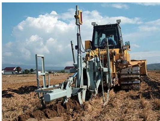
無材暗渠(カッティングドレーン工法)の施工
