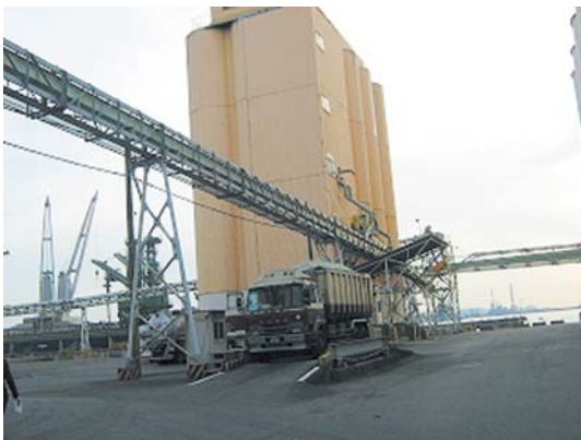
写真3 小麦備蓄サイロ
