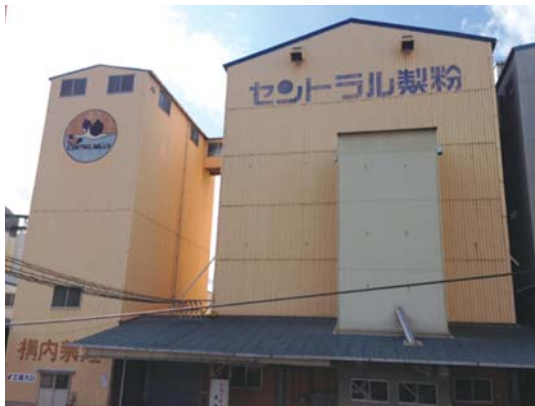
写真1 セントラル製粉(株)会社全景
