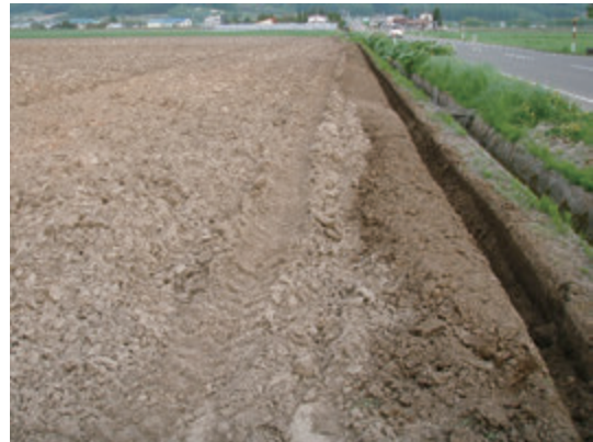
写真3 溝切りによる額縁明渠
