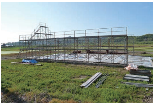
写真3 建設中の乾燥施設
