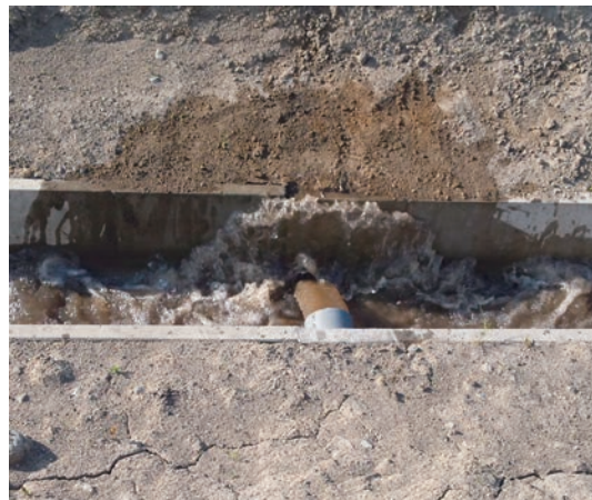
写真4. 暗きょ管の清掃状況
