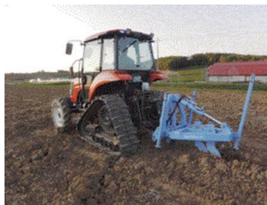
写真5 カットドレーン施工
