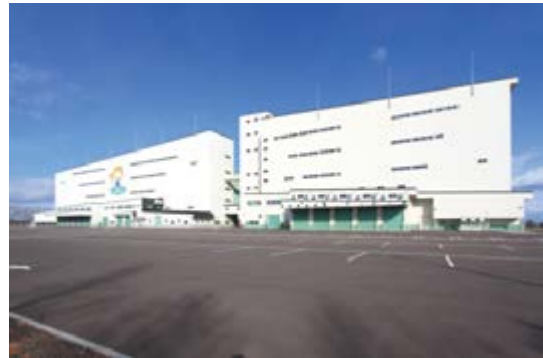
写真1 網走市麦類乾燥調製貯蔵施設
