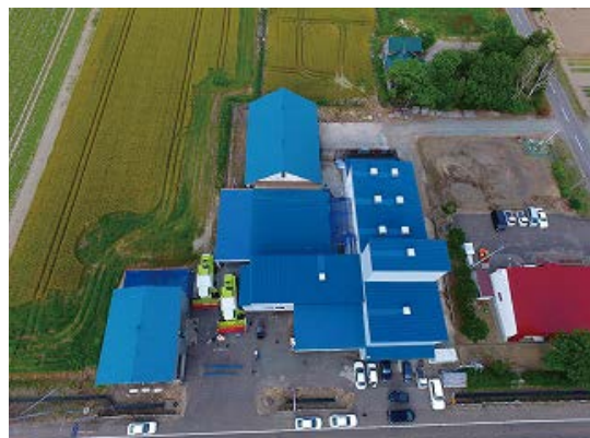
写真5 岐阜コントラクター全景
