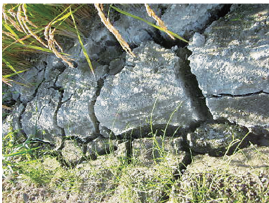
写真4 大きく亀裂の入ったほ場
