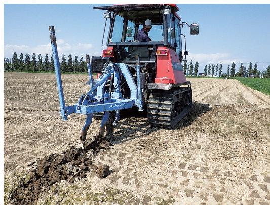
写真 5 カットドレーン施工
