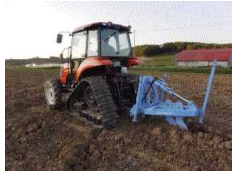
写真3 カットドレーンの施工
