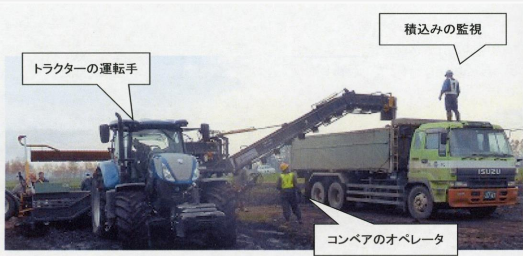
写真 2-7 移動式除土積込機における監視作業
