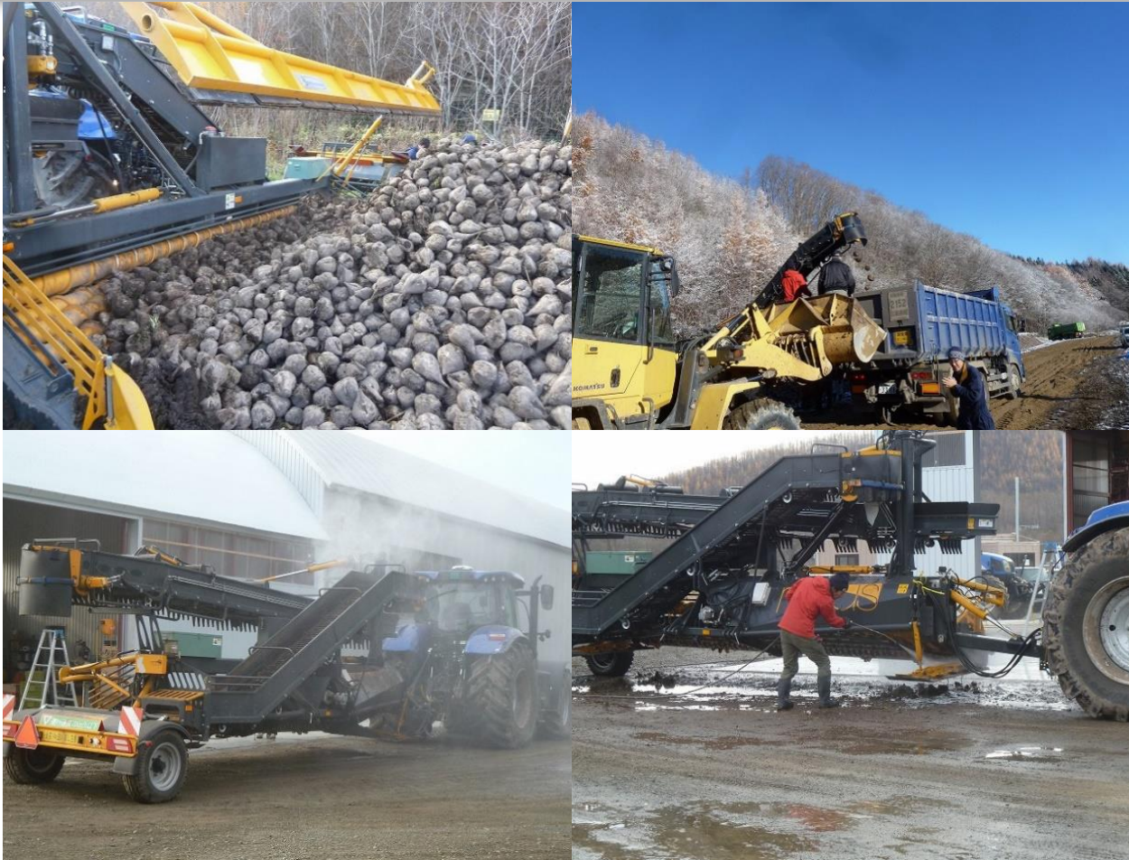
写真 2－4 移動式除土積込機による積込と洗浄作業
