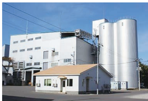
写真4 麦類乾燥調整貯蔵施設
