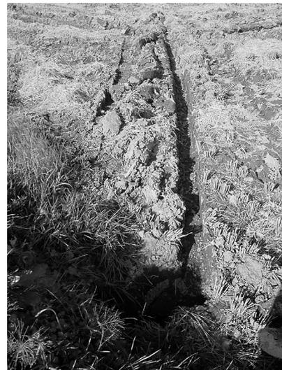
写真7 泥濘部分は深く溝を切り落水口につながれている
