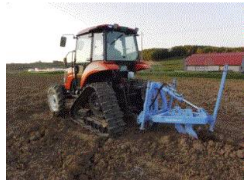
写真3 カットドレーンの施工
