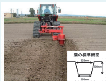
《ほ場内明渠の施工状況》 (秋まき小麦のは種直後)
