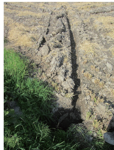
写真2 落水口につなげた溝
