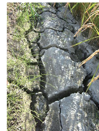
写真3 大きくヒビ割れた水田
