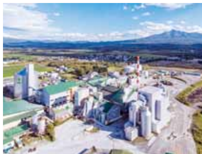
ホクレン中斜里製糖工場
