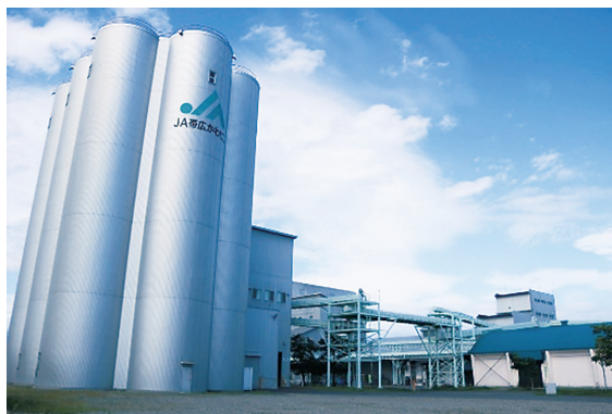
写真2 麦類乾燥調製貯蔵施設
