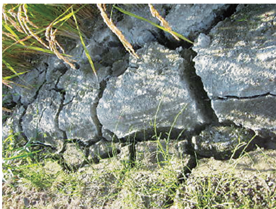
写真 4 大きく亀裂の入ったほ場 (R3. 8/末、空知管内 A 町)
