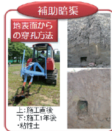
図7 カットドレーンの外観と施工の概要
